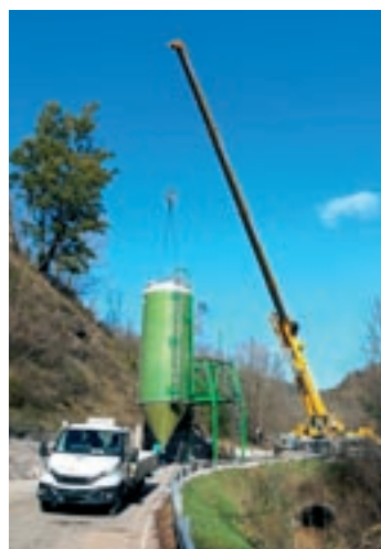
Una grua instal·lant la sitja
