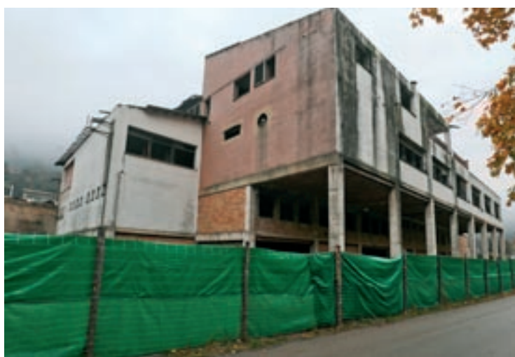
La planta ocuparà un miler de metres quadrats de l'actual edifici
