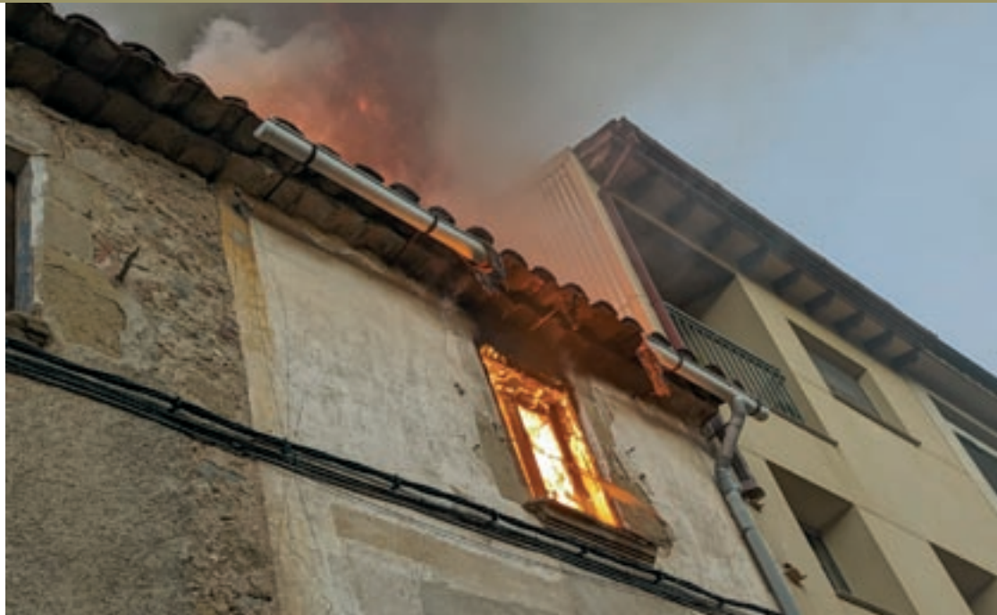
El foc, que es va desenvolupar en una de les habitacions de la segona planta, va trencar la finestra i va ensorrar la teulada
