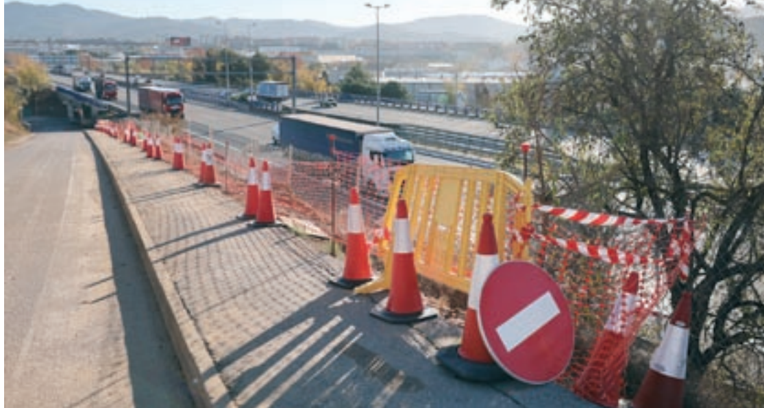
Els treballs ja són visibles al costat del carrer que dona accés a Can Tabola des de la carretera de Vic (BV-5003)
