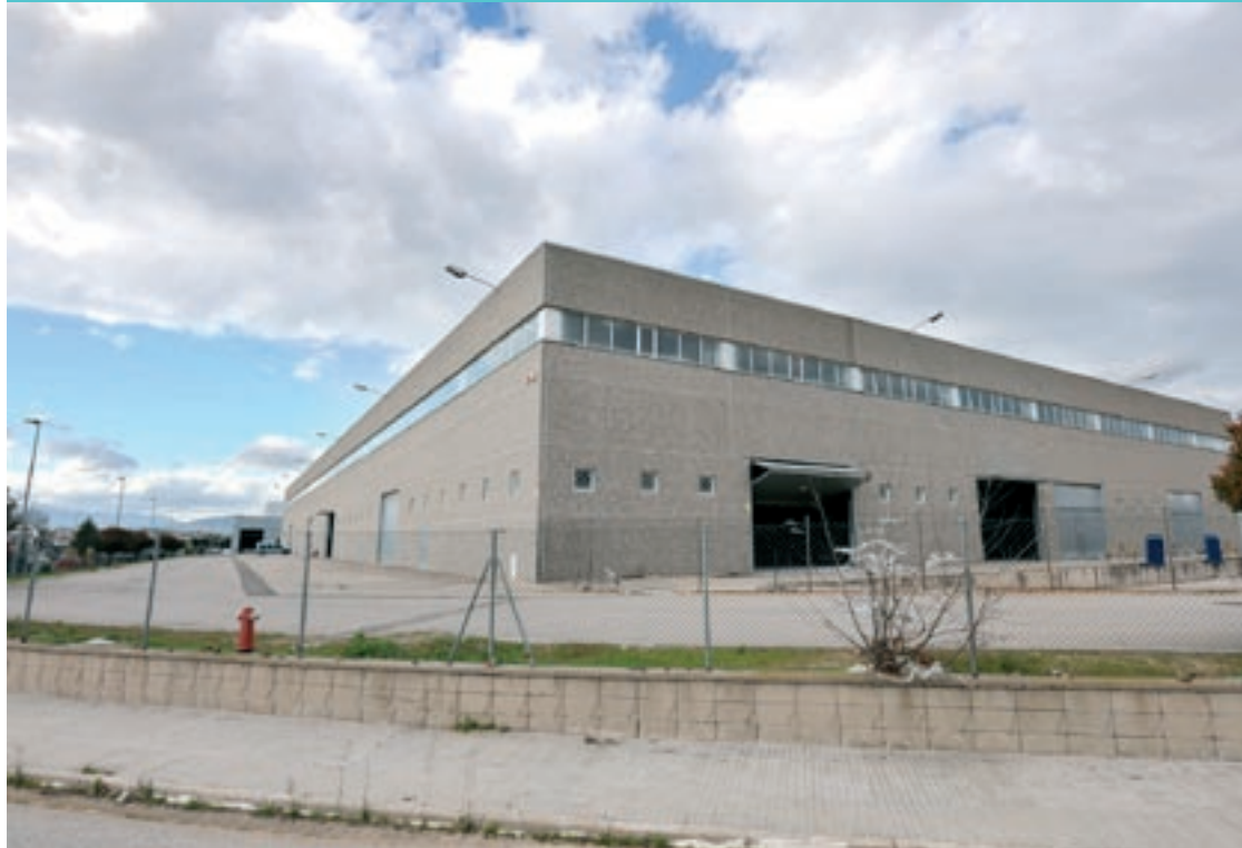
MAM ocupa a Martorelles unes instal·lacions de 14.000 metres quadrats des de principi de 2020
