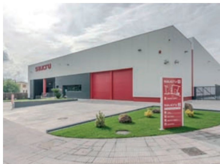
Instal·lacions logístiques de Salicru a Santa Maria de Palautordera
