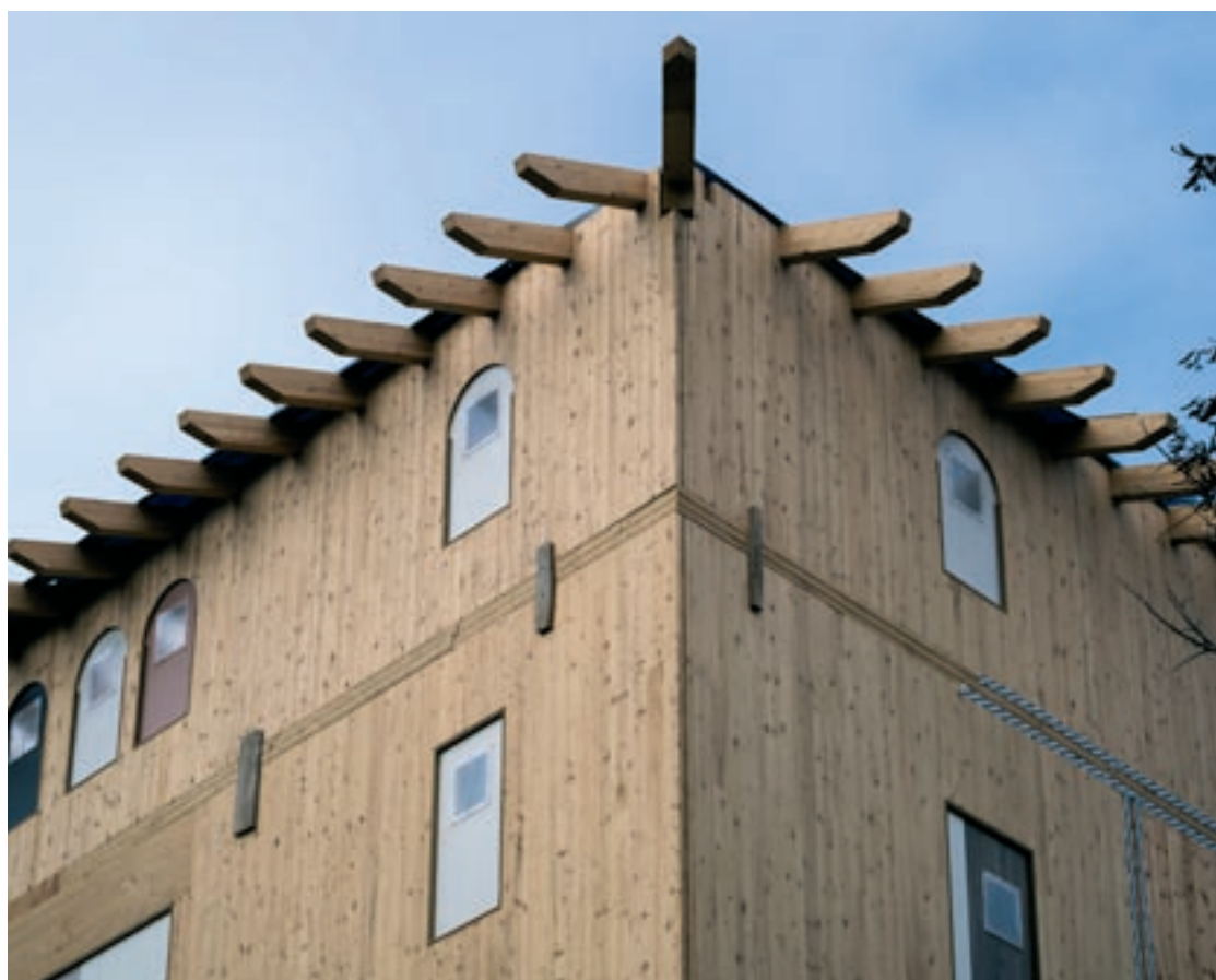
A dalt, l'arquitecta Dolo Rovira i els propietaris de l'habitatge, Josep Bau i Àngela López; a sota, imatge de la façana
