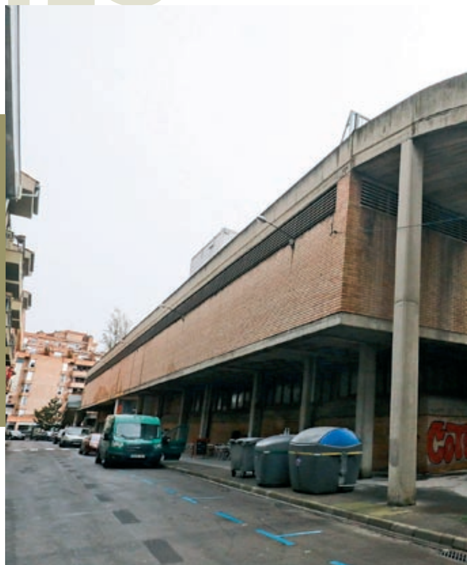
Vista del Mercat Municipal de Vic des de sota l'accés a l'aparcament, una de les rampes que
