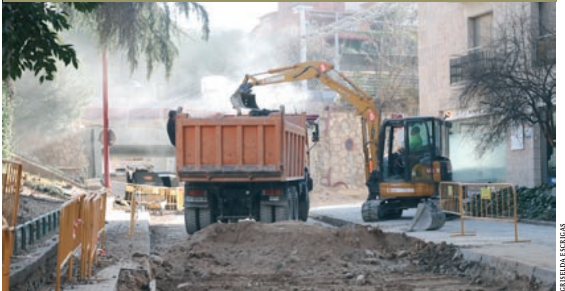
Estat dels treballs aquest dijous al matí al passeig dels Til·lers, on s'ha renovat el clavegueram i altres serveis
