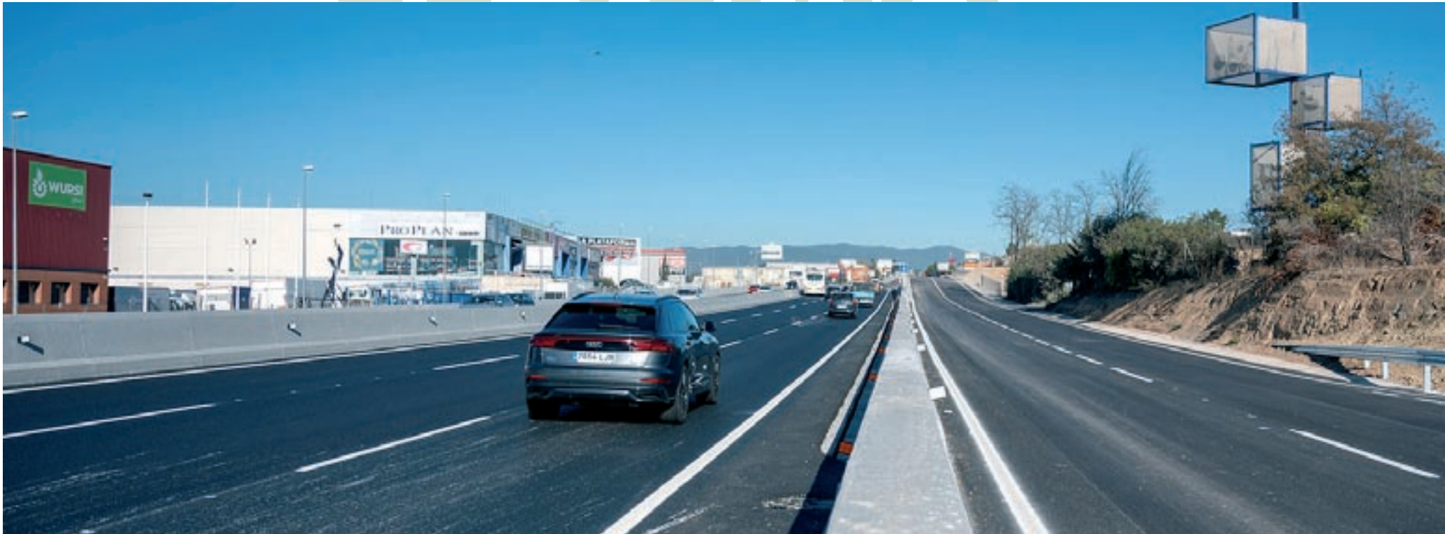
La nova calçada de la C-17 en direcció nord ampliada a tres carrils amb el nou vial lateral que canalitza tots els accessos a les empreses situades a peu de carretera i elimina les perilloses connexions directes a l'eix principal.
