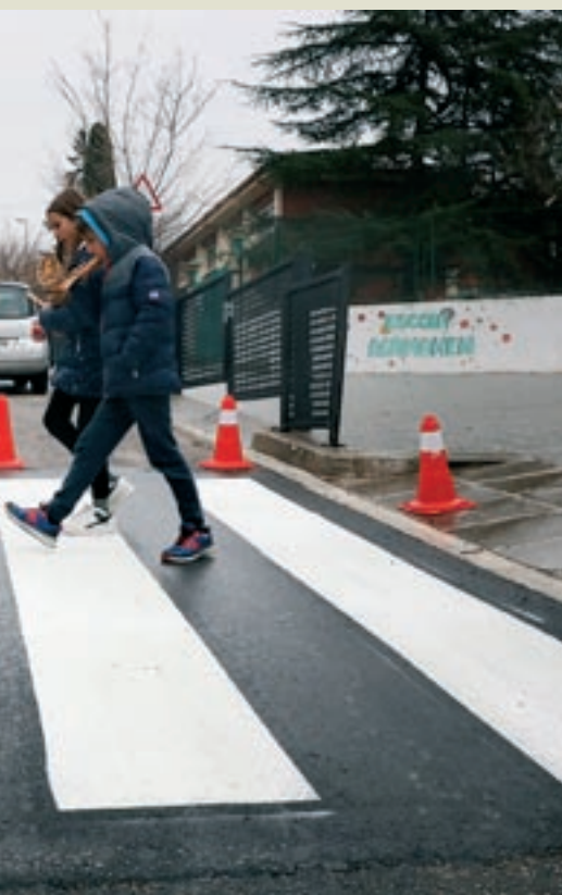
an el pas s’acaba de pintar al tros repavimentat
