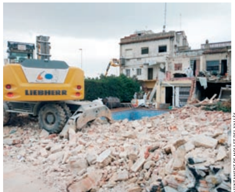
Dimecres es va fer l’enderroc dels edificis que hi havia a la futura plaça
