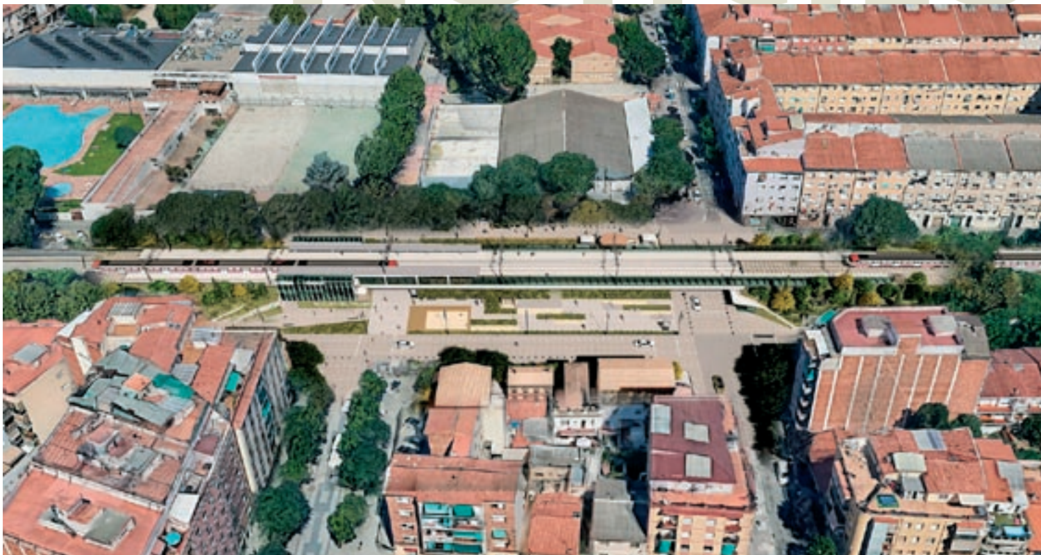
Imatge virtual del tram central de l'R3 desdoblada a Mollet amb un viaducte obert per sota per garantir la permeabilitat entre barris i la nova estació
