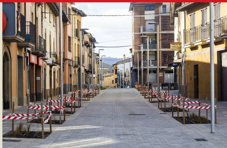
Aspecte de com ha quedat el remodelat carrer Gran de Calldetenes
