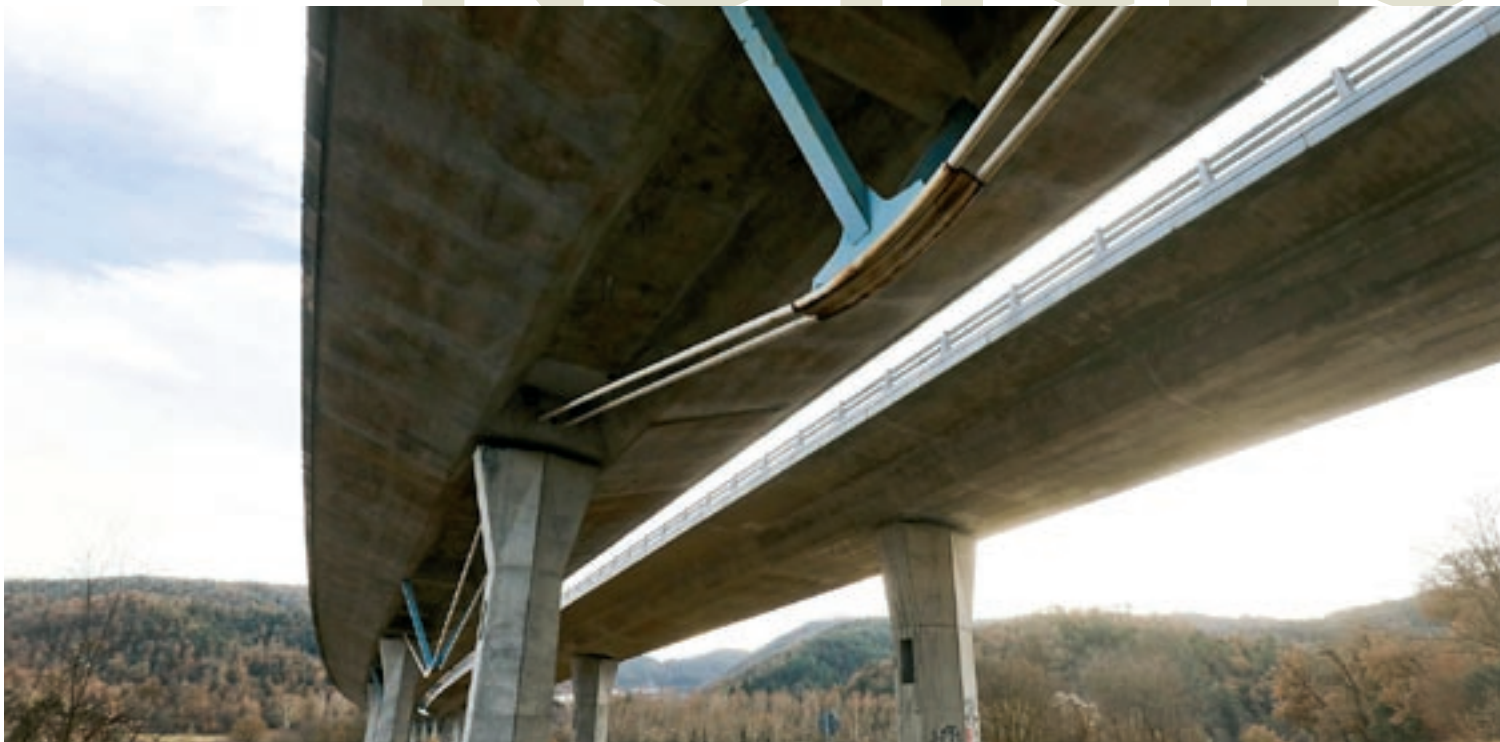
A la imatge es poden veure els tirants que subjecten el pont per sota i que amb el pas del temps s'han rovellat fins a quedar malmesos
