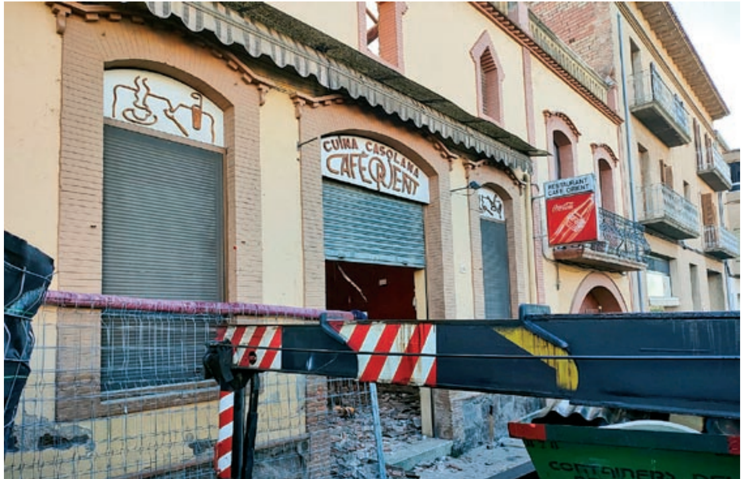
Aquests dies han començat les obres de rehabilitació de l'històric Teatre Orient de Prats de Lluçanès
