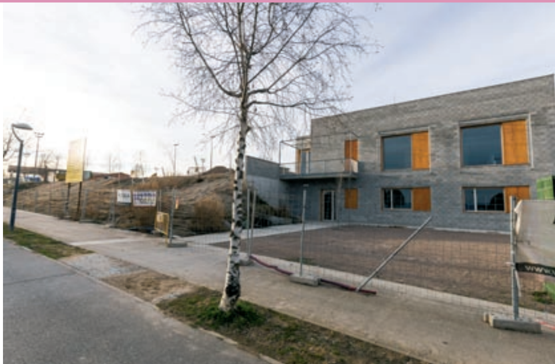
A la banda esquerra, el punt on s'han començat a construir les 17 habitacions. A la dreta, el centre de serveis
