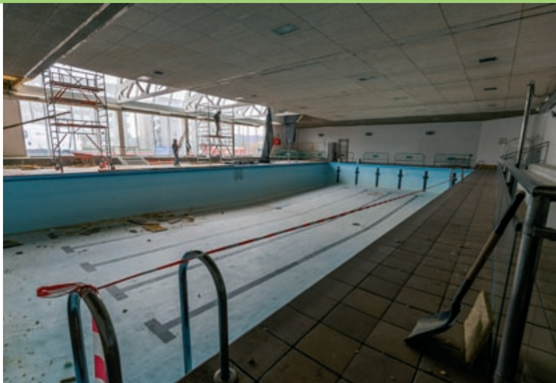
Vista de la piscina coberta amb l'inici de les obres i, al lateral, la vidriera que s'obrirà per connectar amb l'exterior
