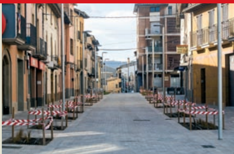
Aspecte de com ha quedat el remodelat carrer Gran de Calldetenes
