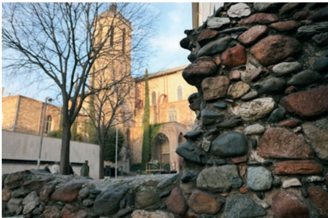
A dalt, el corredor de la Constància. A baix, un tram de la muralla a la plaça de l'Església
