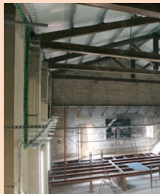
La sala del teatre ha estat en obres durant anys
