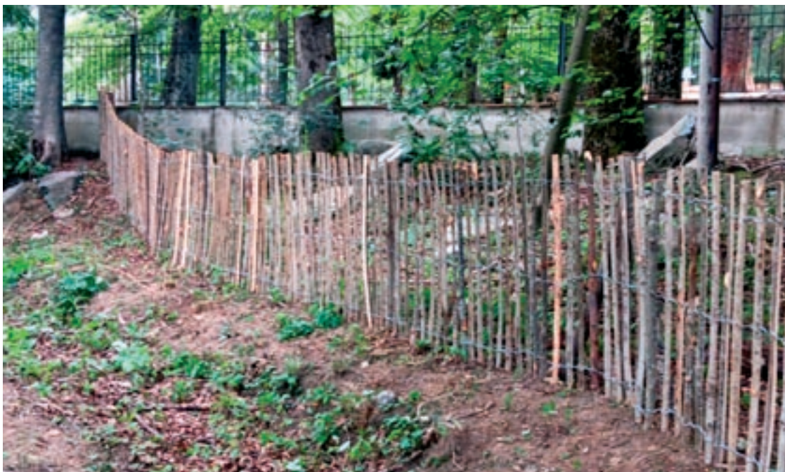
Les tanques amb fusta de castanyer que s'han instal·lat per protegir les basses i zones humides a la vall de Santa Fe
