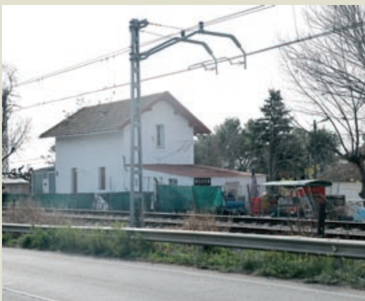
Una de les cases d'Adif a tocar de la via que s'haurà d'enderroc
