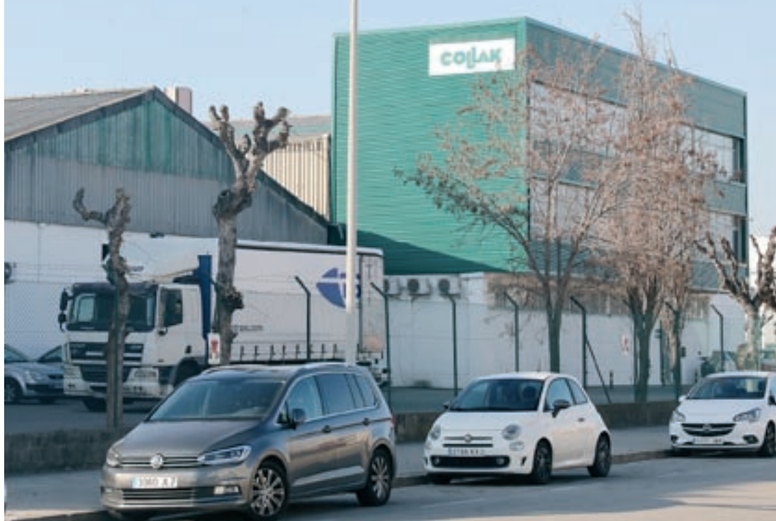
Collak disposa de més de 14.000 metres quadrats d'instal·lacions al polígon del Pla de Llerona
