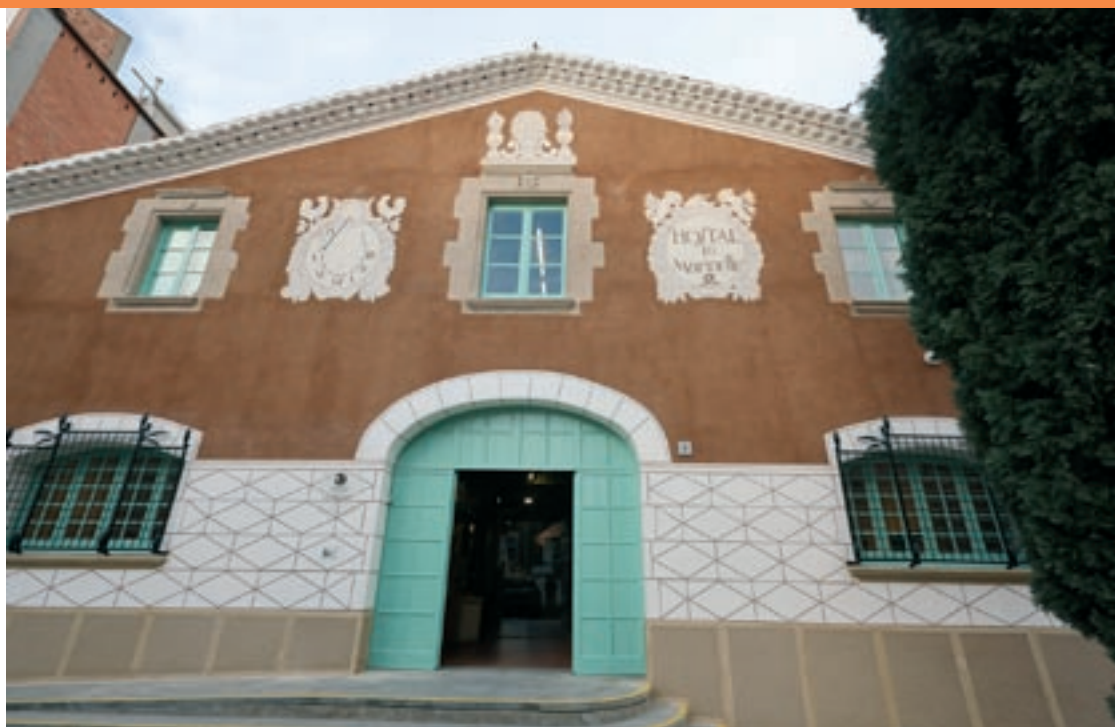
Aspecte actual a La Marineta després de les obres de rehabilitació
