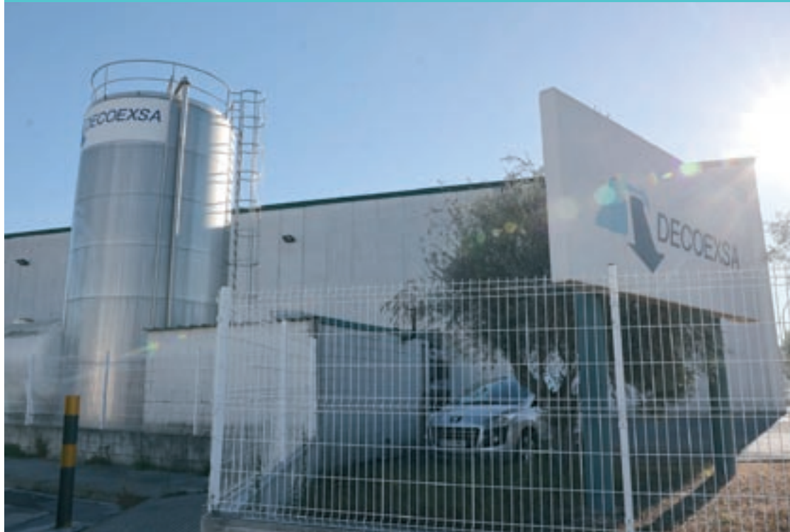
Les noves instal·lacions estan adequades a les normatives sobre emmagatzematge de mercaderies perilloses
