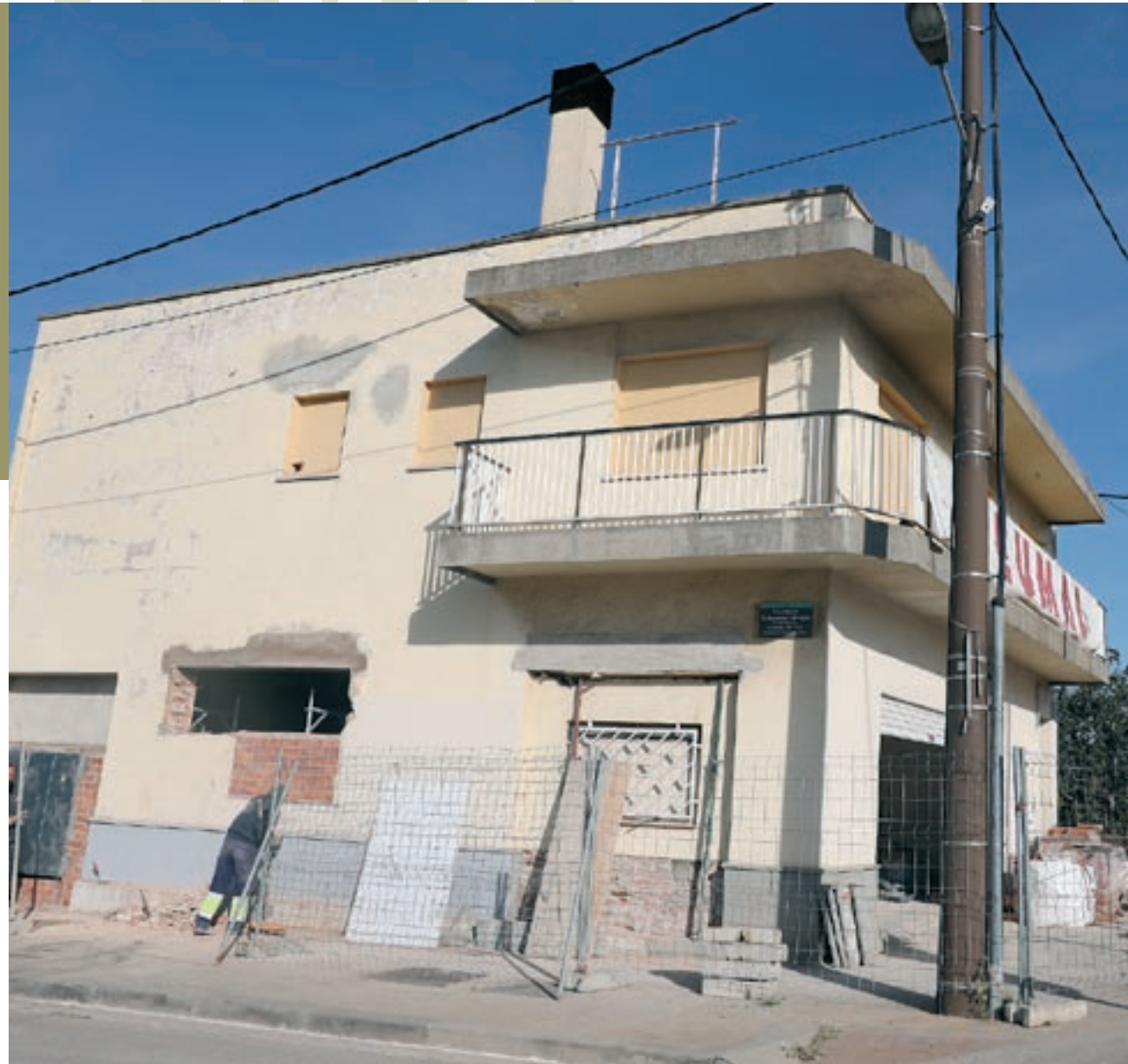
Les obres d'adequació d'una casa de Palou per convertir-la en allotjament temporal de persones en situació d'emergència habitacional, a
