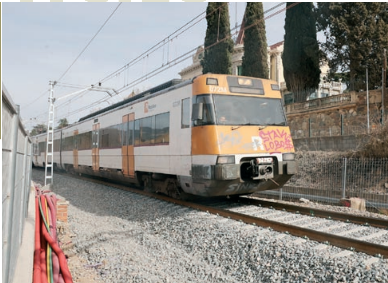
Un comboi de la línia R3 circulant aquest dijous al matí pel tram en obres situat just al sud de l'estació de la Garriga
