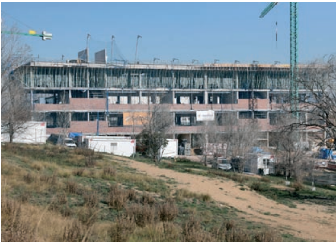
L'edifici Campus Fundació s'està construint al costat de la Ronda dels Pinetons, prop de l'Hospital
