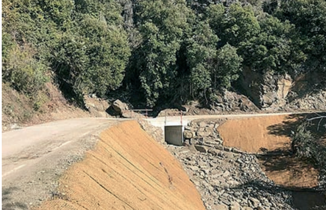
Resultat final de l'actuació amb el nou pont, el llit del torrent naturalitzat i els marges consolidats i amb plantacions
