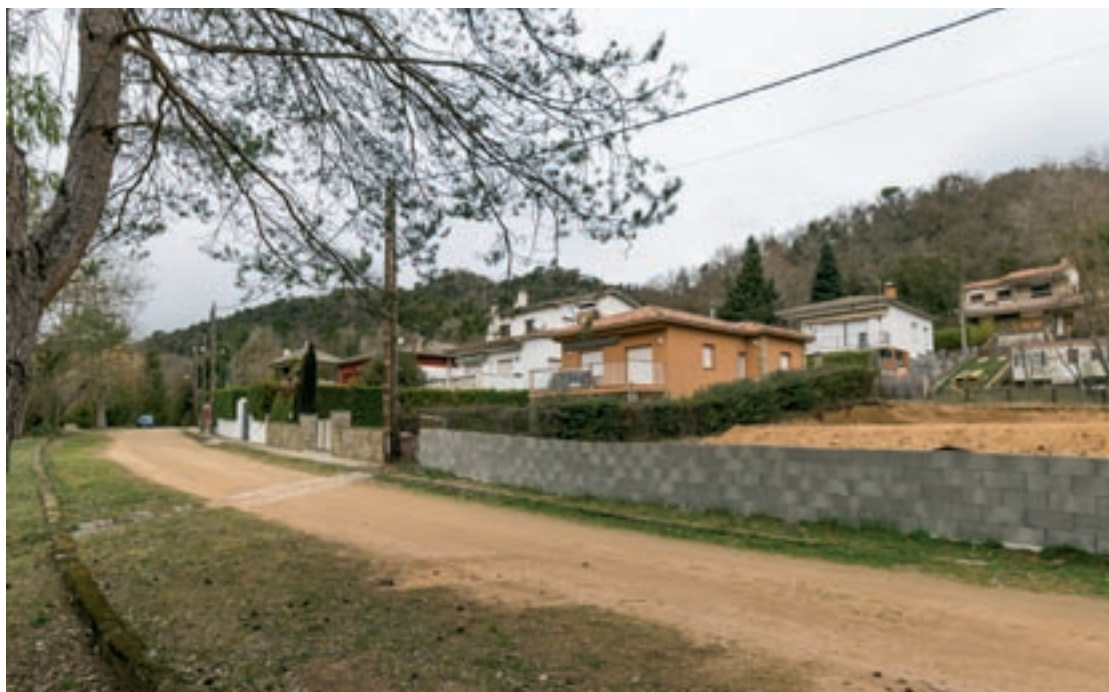
Bojons, a Sant Sadurn d'Osormort, té alguns vials sense asfaltar
