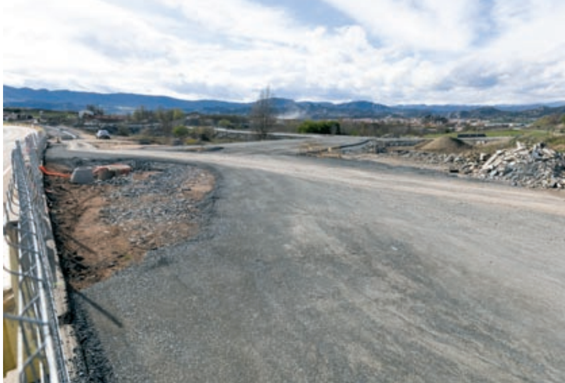
Les màquines ja fa unes setmanes que tornen a treballar al polígon de la Caseta
