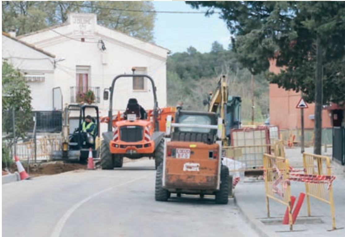
Les obres al tram urbà de Corró d'Amunt de la carretera BV-5151 van començar el 26 de febrer
