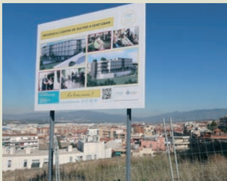
Un cartell anuncia la construcció de la residència de Bellavista
