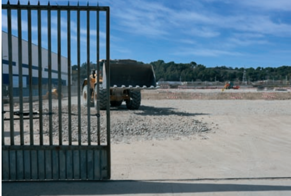
Una excavadora treballava la setmana passada en els fonaments de la nova promoció logística al polígon de Palou Nord
