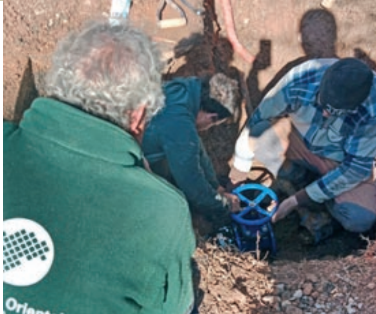
Uns operaris reparaven la fuga a la xarxa divendres passat al migdia
