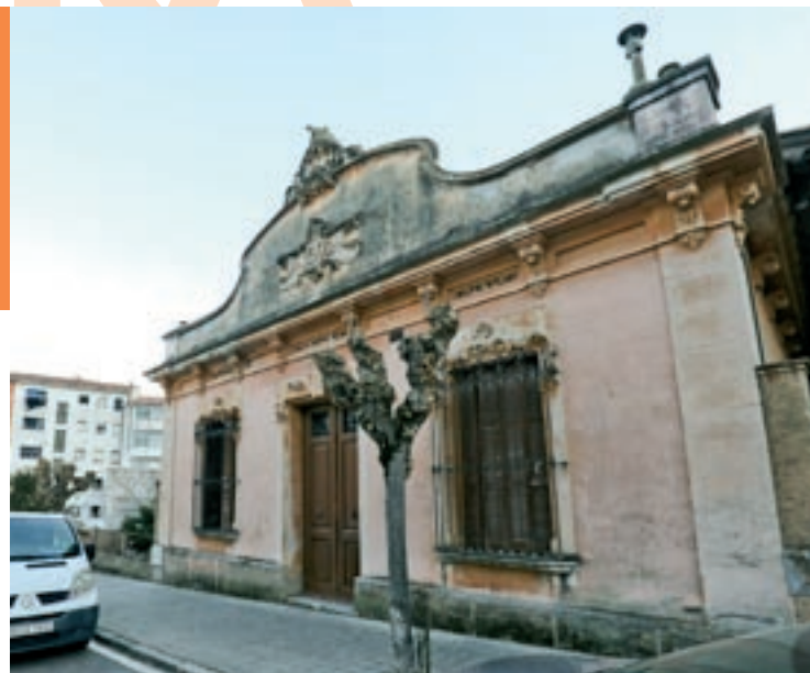
Aspecte exterior actual de la Casa Pujol de Centelles
