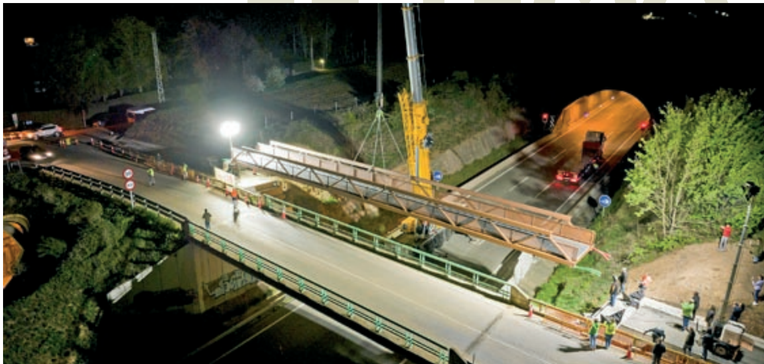
L'estructura va ser portada a punt per col·locar amb les baranes i pintada de color marró
