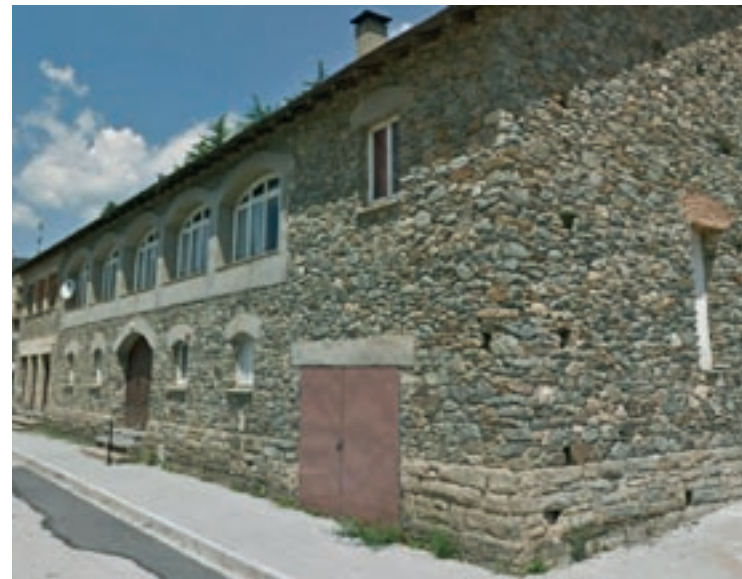
Imatge de l'exterior del Casino de Planoles
