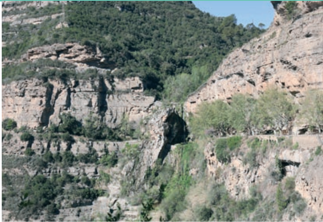
La zona de la cinglera de Sant Miquel del Fai on hi va haver el desprendiment i on es faran nous treballs de consolidació
