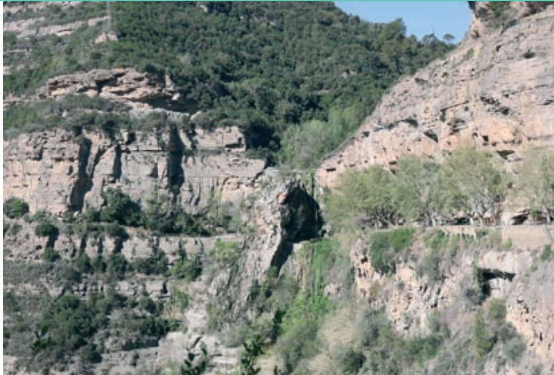
La zona de la cinglera de Sant Miquel del Fai on hi va haver el desprendiment i on es faran nous treballs de consolidació
