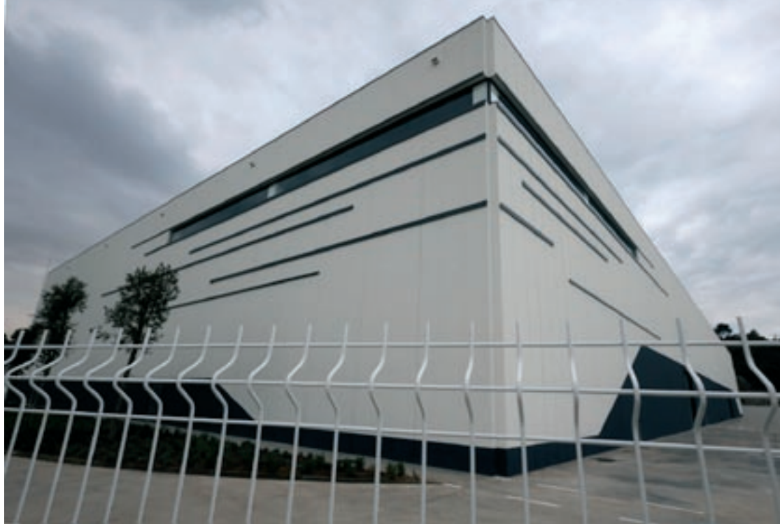
L'edifici construït sobre el solar de l'antiga Bimbo és una de les promocions que es comercialitzen a la comarca
