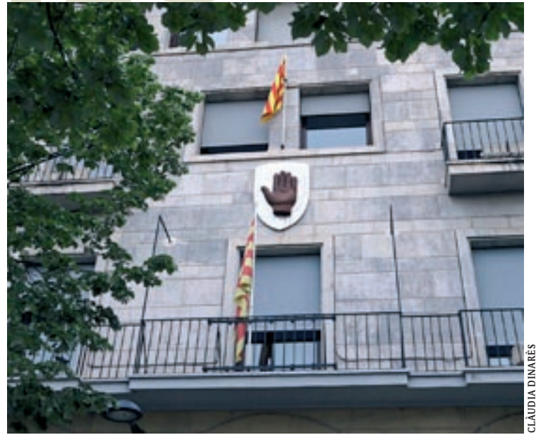
Vista de la façana de l'Ajuntament aquest dijous, ja sense l'estelada
