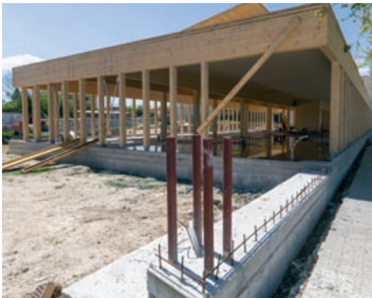
Vista de l'estructura de fusta
