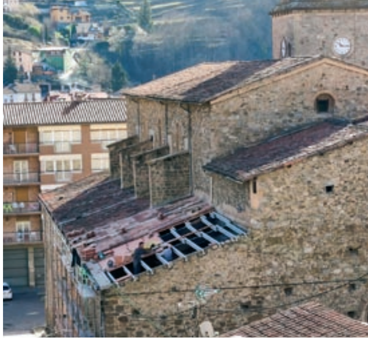
Treballs a la teulada, a la zona on es va fer un forat
