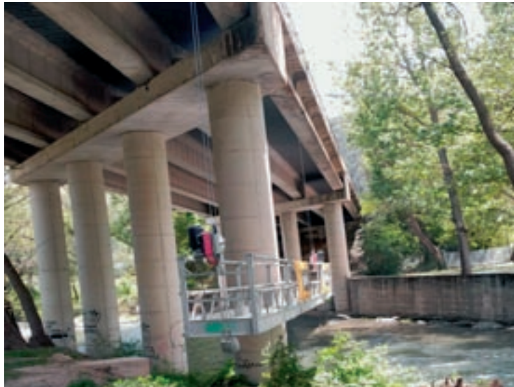
El lloc on han començat les obres
