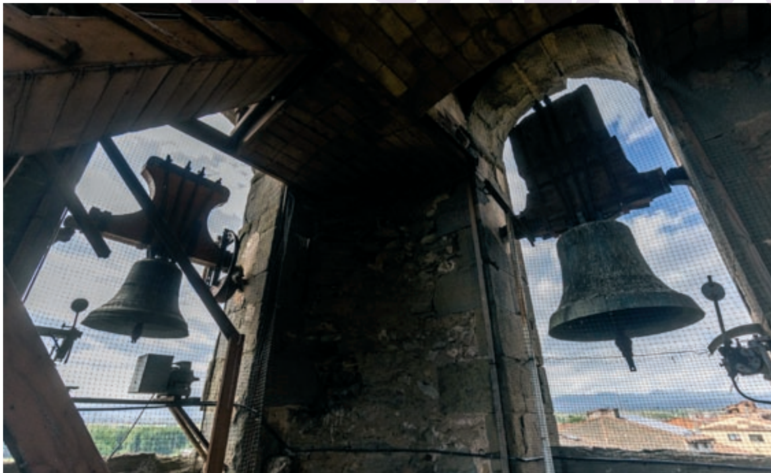
Imatge de dues de les tres campanes en funcionament, actualment mecanitzades. Per arribar a aquesta alçada del campanar cal superar 103 graons. Val la pena
