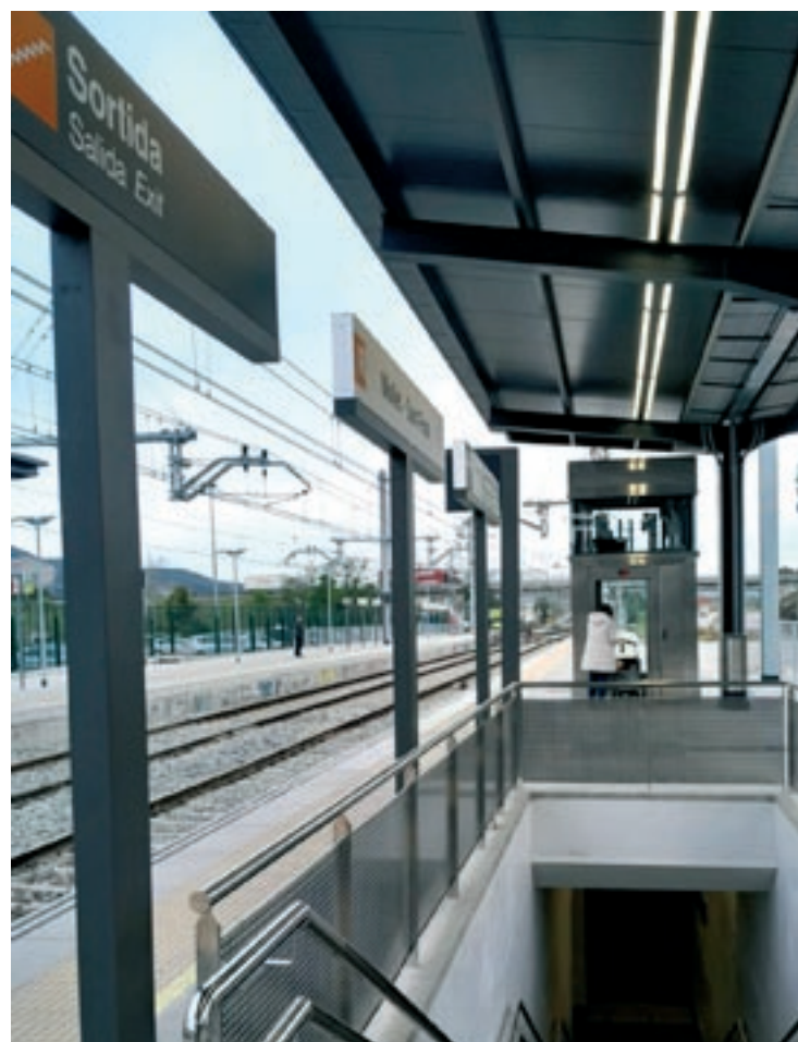
Els nous ascensors i l'accés per escales al pas sota les andanes que s'ha fet
