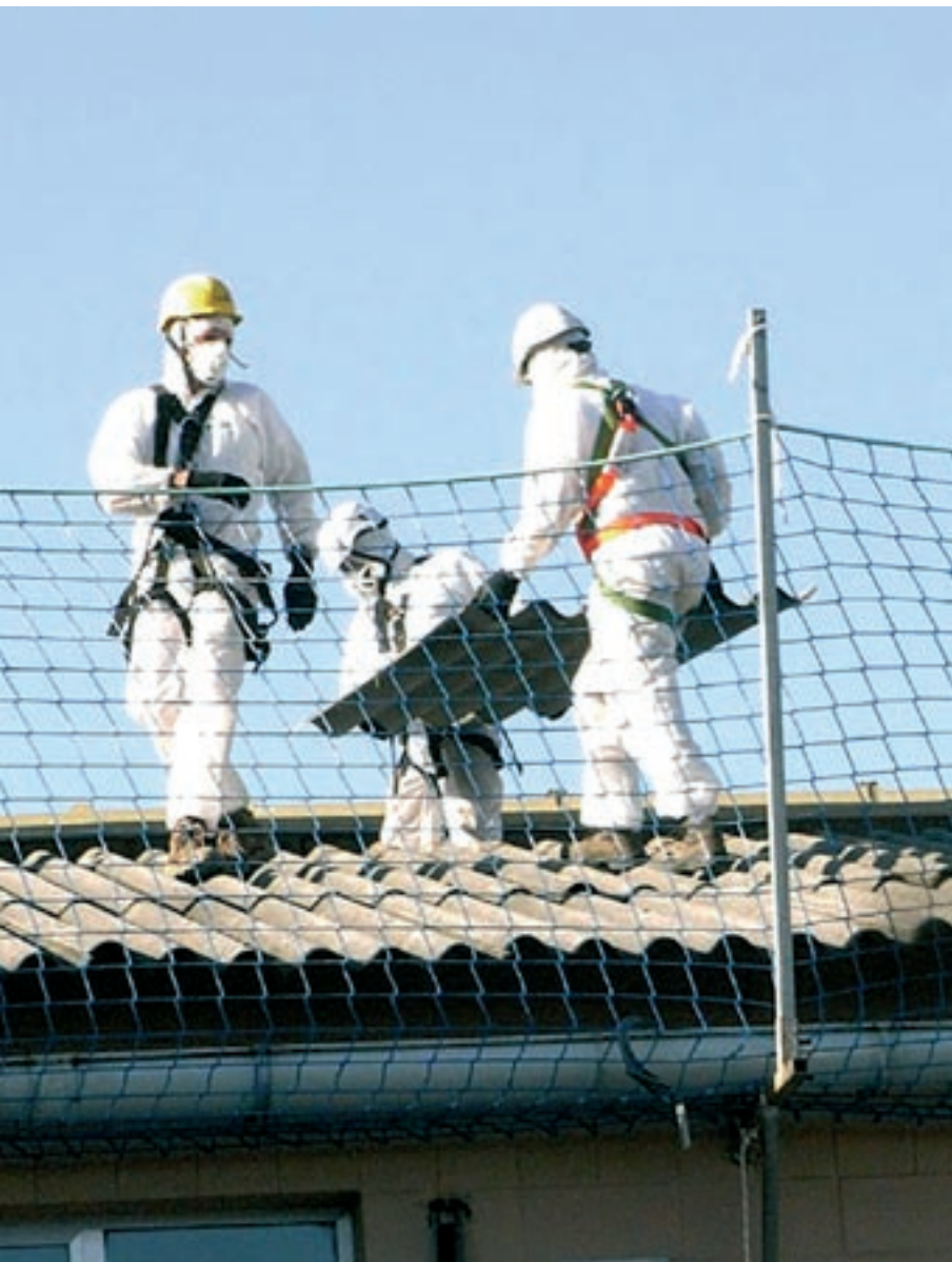
L'empresa Verdmon, de Granollers, retiren amiant en una coberta de Sant Antoni de Vilamajor
