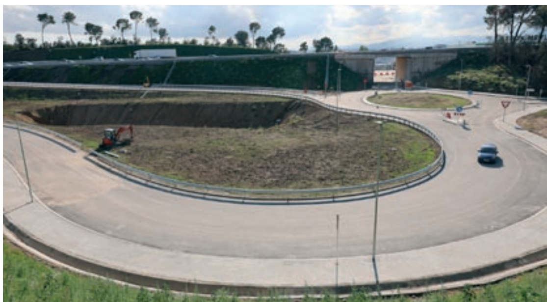
La nova rotonda del costat est de la C-17 amb el nou accés al polígon Font del Ràdiu i el pas per sota de la C-17
