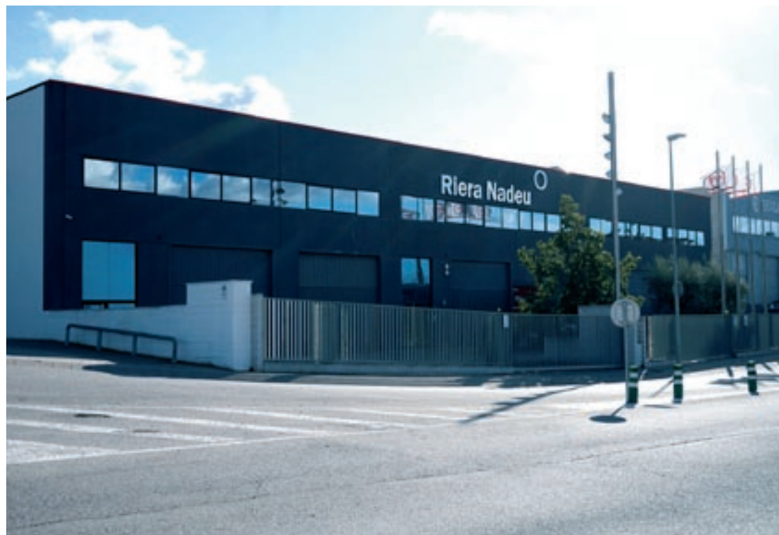
Instal·lacions de Riera Nadeu al polígon industrial del Coll de la Manya
