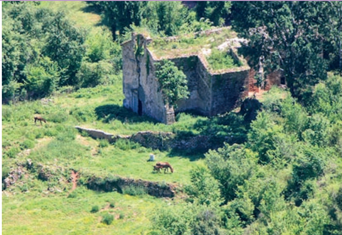
Les restes de l'església de Sant Pau de Montmany, una de les fotografies incloses a la guia
