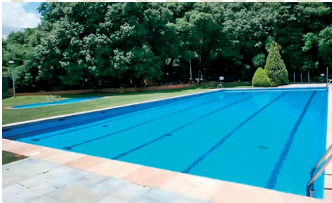
Les instal·lacions de la piscina de Ca l'Arenys, que estan a punt per arrencar temporada en els propers dies
