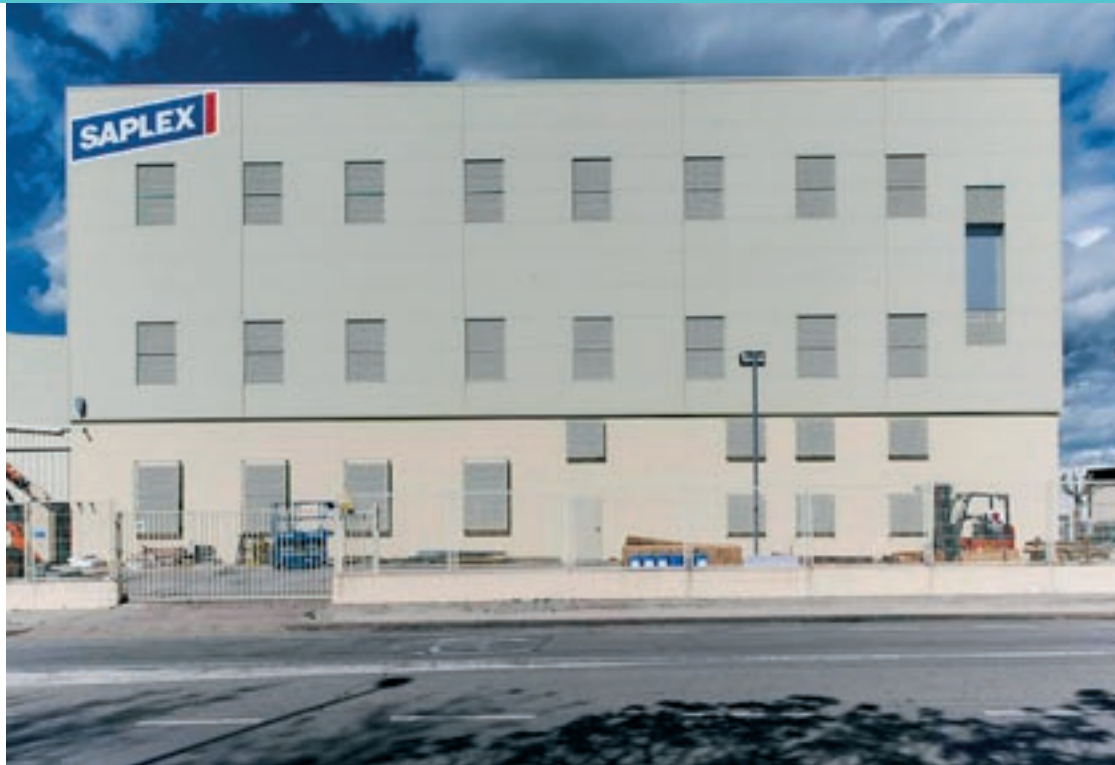
Instal·lacions de Saplex al polígon Can Castells de Canovelles
