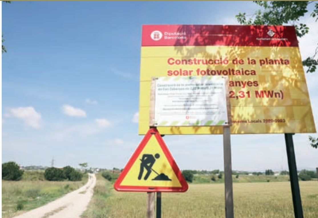
La planta fotovoltaica a Palou tindrà més de 4.600 panells distribuïts en unes quatre hectàrees
