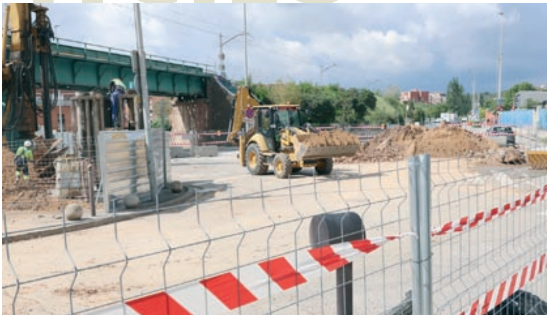
Els treballs a l'entorn del pont del passeig de la Ribera aquest dijous al matí
