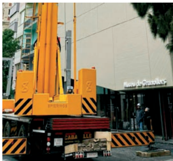
La grua instal·lada aquest dimarts davant del Museu
