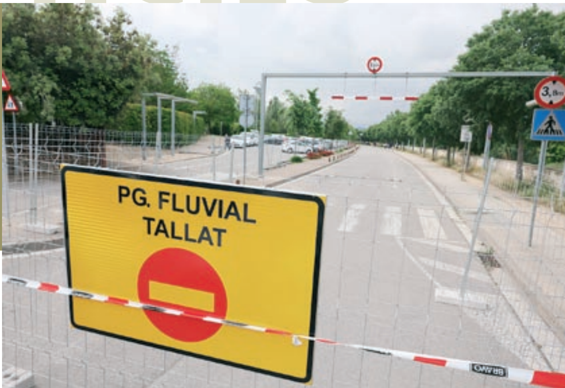
L'empresa que executa els treballs ha arrencat amb la delimitació dels espais afectats per l'obra on s'ha tancat l'accés
