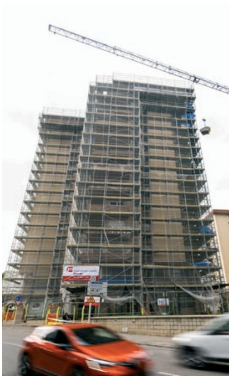
Els 10 pisos de l'edifici Tarragona, sumats a la planta baixa i l'entresol
