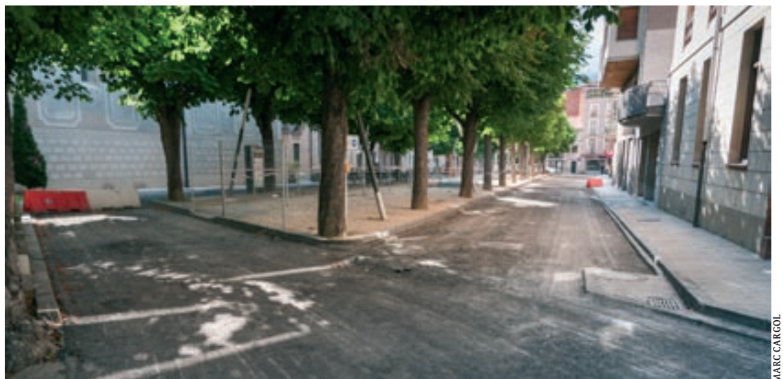
Vista del passeig aquest cap de setmana, ja en obres
