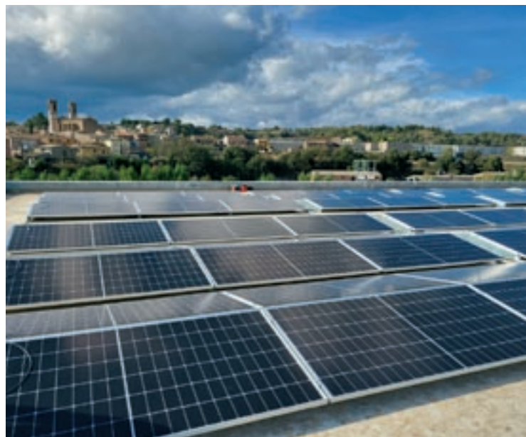
Aspecte de la coberta instal·lada al pavelló municipal
