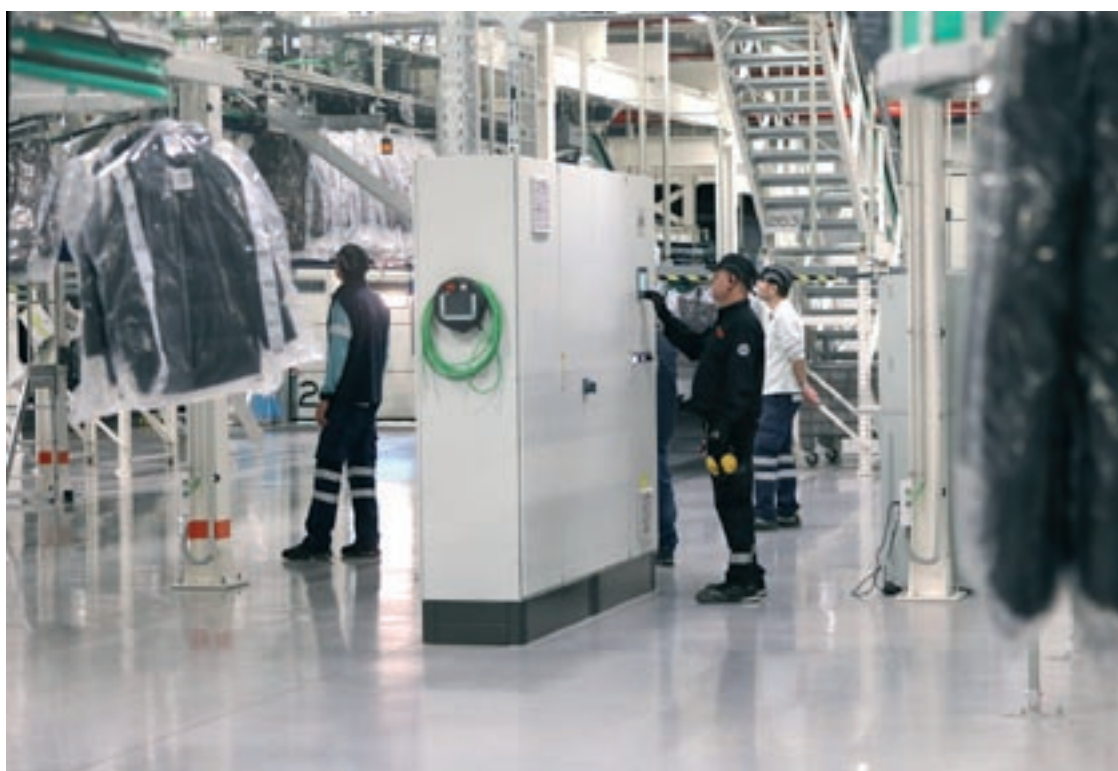
Aspecte interior del centre logístic de Mango a Lliçà d'Amunt
