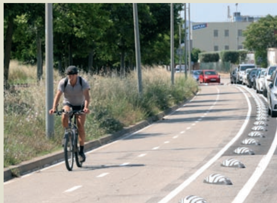
El carril bici té tres metres d'amplada, 2,2 per a les bicicletes i 0,80 de separació amb la filera d'a
