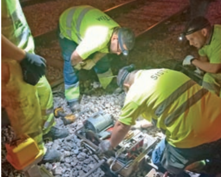
Treballs de reparació dels mecanismes dels canvis d'agulles malmesos
