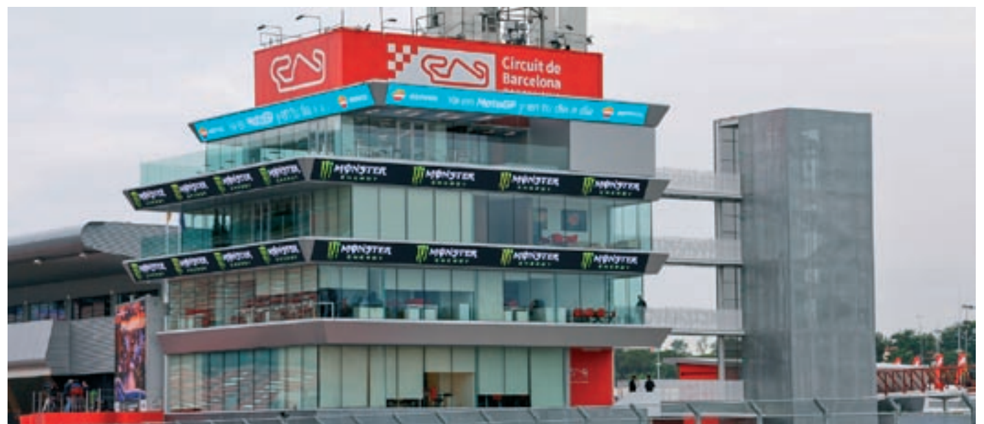
Reforma integral de la torre de control
