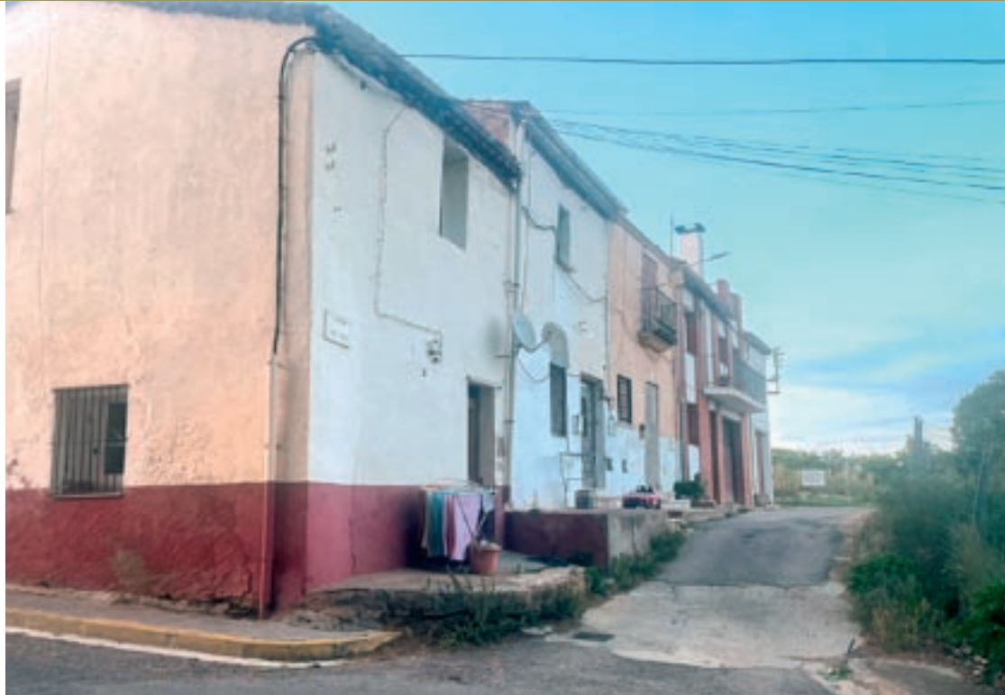
Les cases del carrer Sant Antoni que s'han d'enderrocar per poder continuar la urbanització del sector
