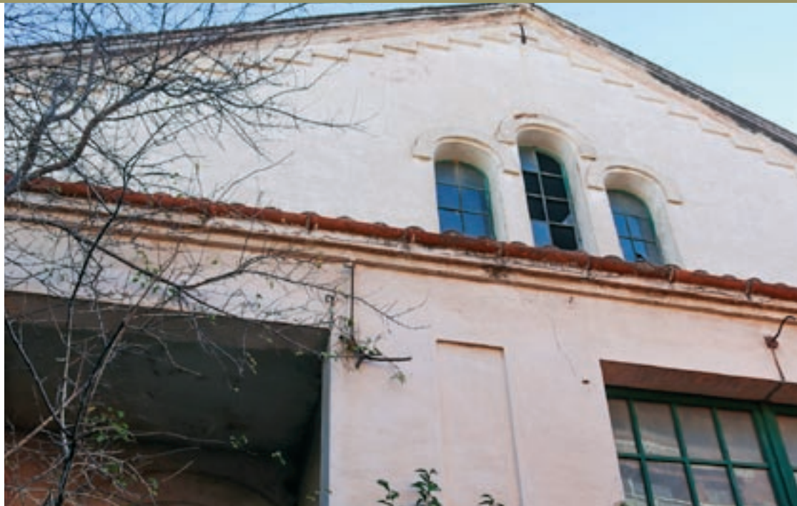
L'estudi de la Diputació posa en valor, entre altres elements, els finestrals, la façana i la coberta amb bigues de ferro
