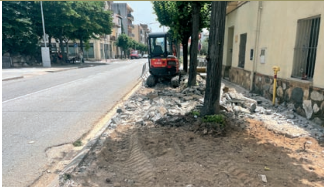
Una retroexcavadora va arrencar dimecres al matí els panots que hi havia al tram de la vorera on va caure la dona
