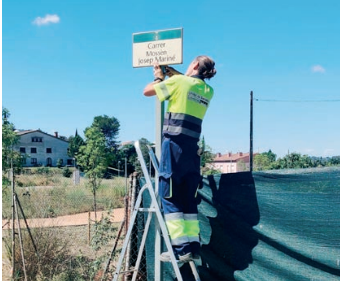
Un operari retira una de les plaques del carrer de Mossèn Josep Mariné a Santa Agnès
