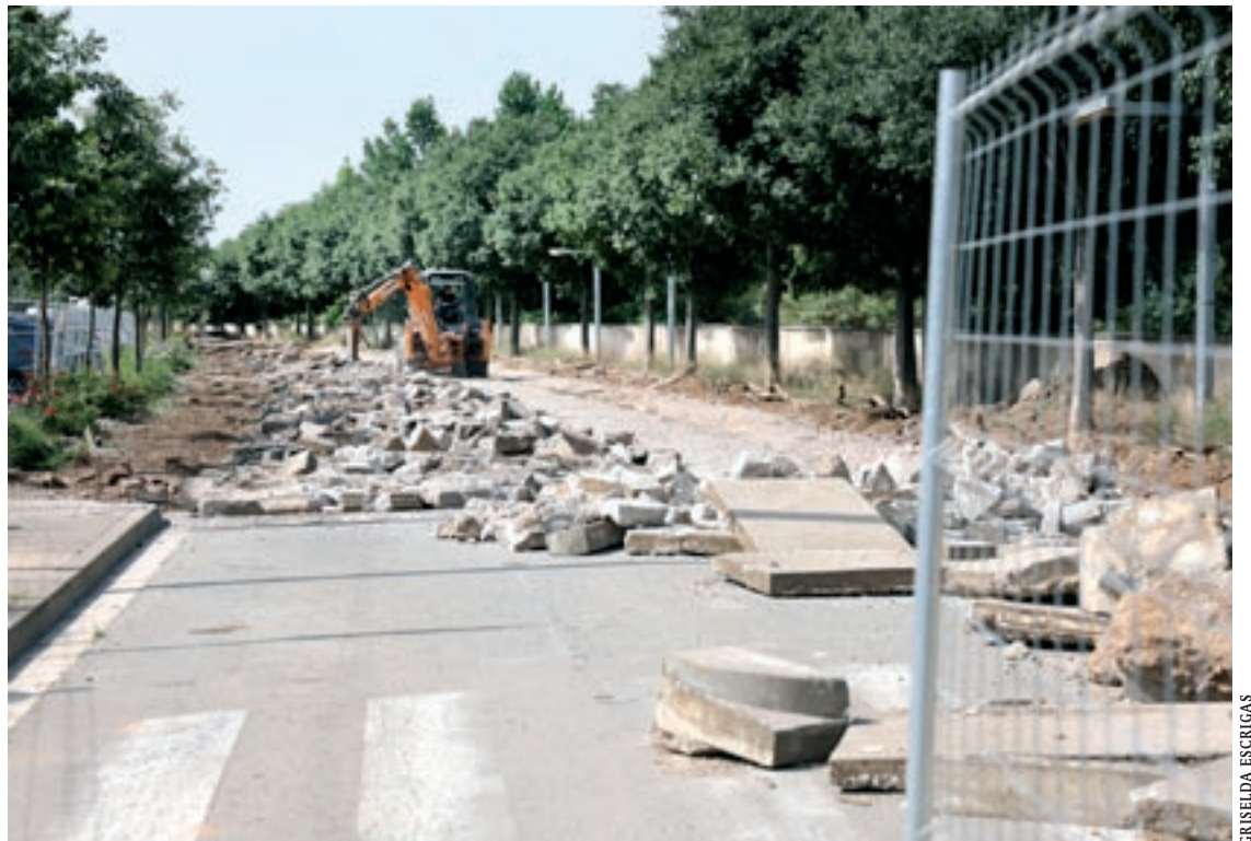
Una màquina excavadora treballava aquesta setmana en la retirada dels blocs que formigó que formaven les voreres
